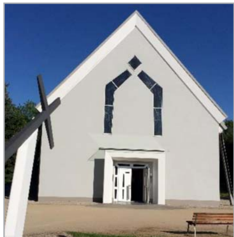
Portal von der St. Hedwigskirche vor (l.) und nach (r.) der Sanierung
